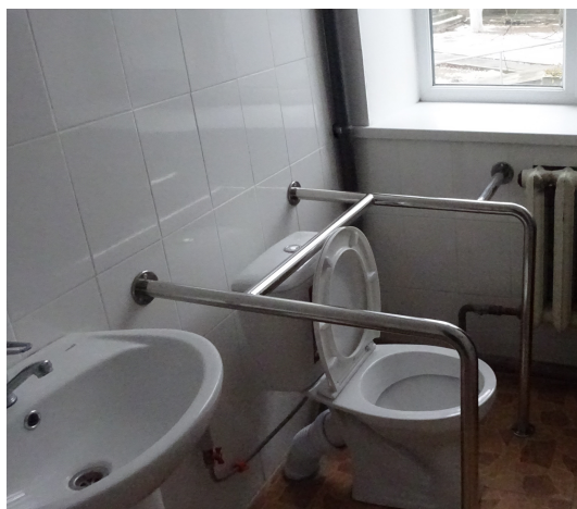
En handikappanpassad toalett är också en nyhet på ålderdomshemmet.
